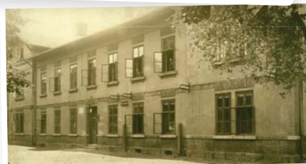
Dobová fotografie budovy sídla Železniční policie
